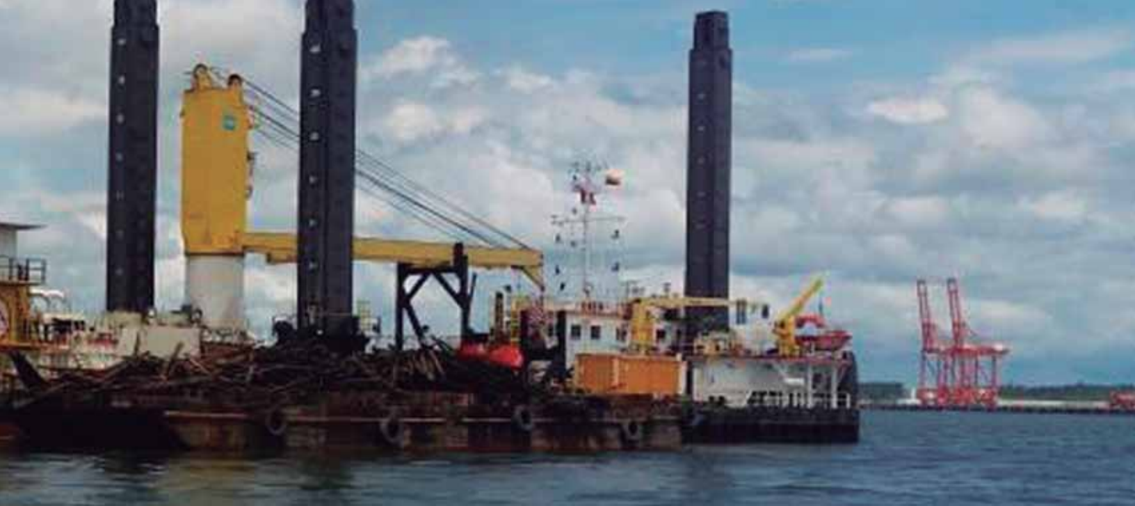
Imagen: Para la extracción de sedimentos se viene utilizando esta retroexcavadora llamada Postnik Yakovlev, considerada la draga de corte más grande del mundo. Foto: Cortesía Invías. Tomado de: http://www.eltiempo.com
